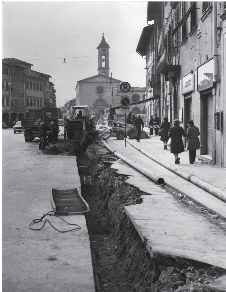
Installazione della rete del metanodotto in Piazza Marsilio Ficino
